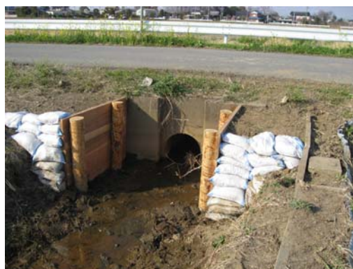
・補修した水路
