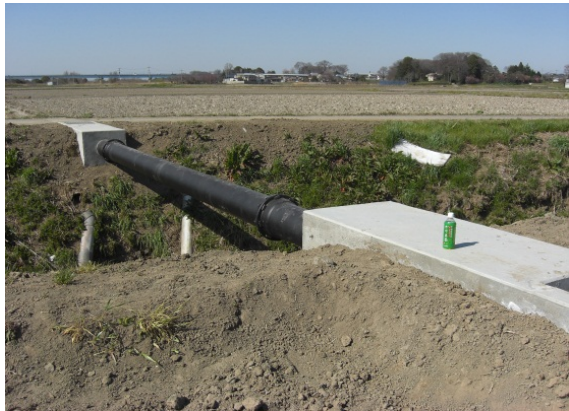
用水路の敷設替え
