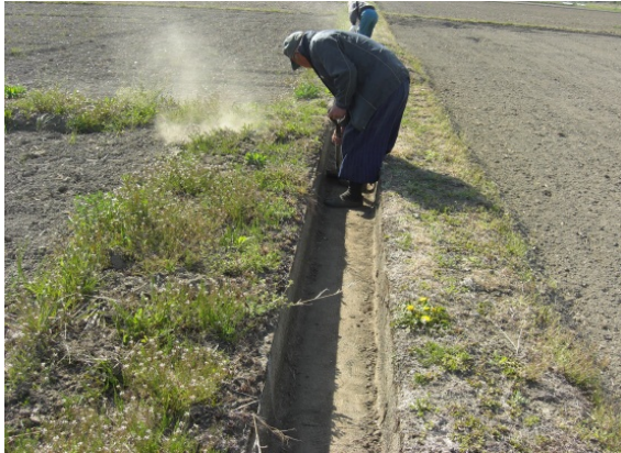
水路の泥上げ
